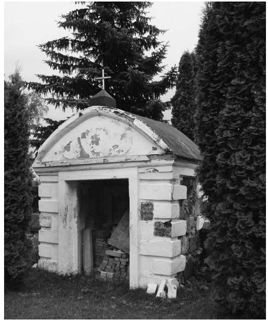
9 pav. Bažnyčios šventoriuje stovinti mūrinė Kryžiaus kelio koplytėlė su fundaciniu įrašu. D. Klajumienės 2012 m. nuotr.
