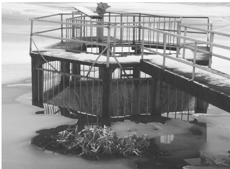
Sintautų tvenkinio vandens nuleidimo šachta žiemą. 2013 m. I. Daniliauskaitės nuotr.
