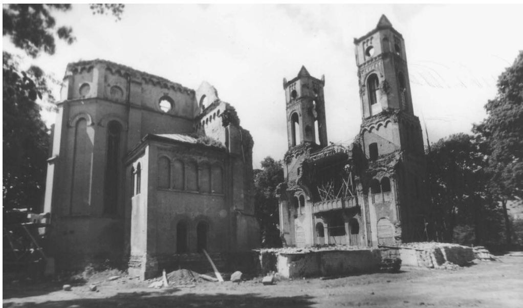
Bažnyčios atstatymo darbai. 1993 m. G. Jokūbaičio nuotr.
