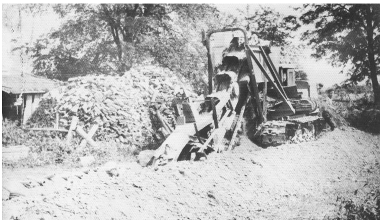
Sausinant mažomis drenažo sistemomis sausintuvai būdavo įterpiami ir į sodybas; drenažas kasamas pirmutiniu daugiakaušiu. 1969 m. Iš R. Jucio rinkinio
