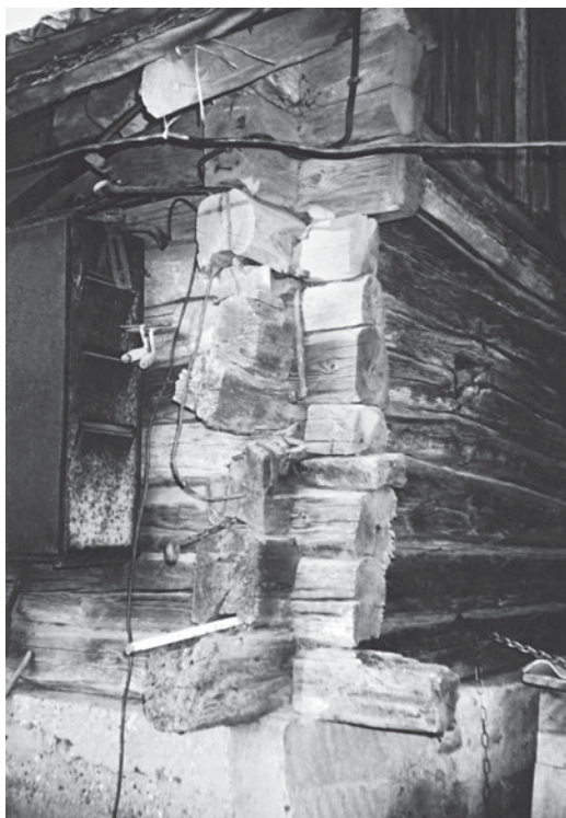
2 pav. Sienojų sunėrimas kampuose („ sūsparos “). 2001 m. E. Straševičienės nuotr.
