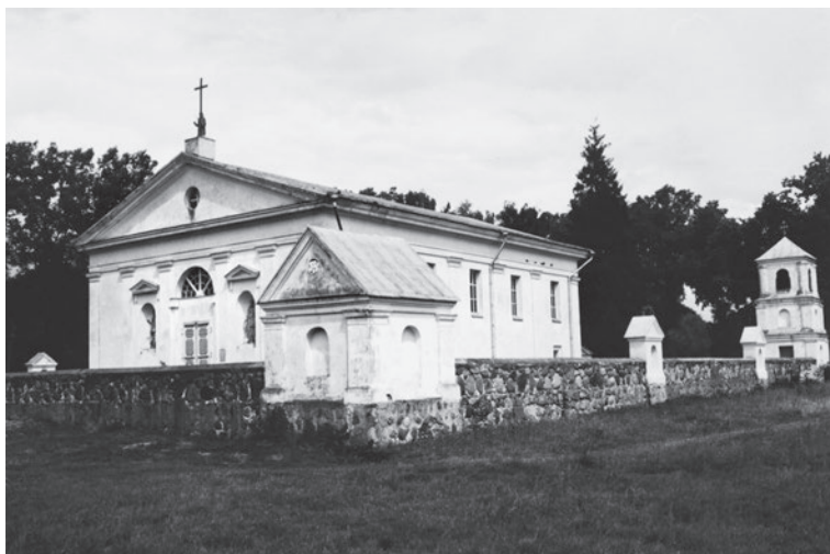
1 pav. Čiobiškio bažnyčios architektūrinis ansamblis. L. Klimkos nuotr.
