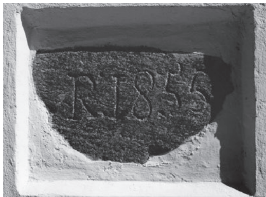
Akmuo su Musninkų mūrinės bažnyčios statybos pradžios data, įmūrytas bažnyčios galiniame fasade. Šoninio ir galinio fasadų vaizdas. 2002 m. A. Petrašiūno nuotr.
