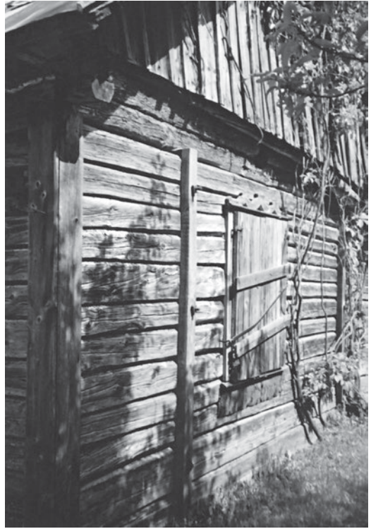
3 pav. Kampuose sunerti sienojai lygiai nupjauti ir vertikaliai apkalti lentelėmis. Ornamentu puoštas antlangis. 2001 m. E. Straševičienės nuotr.
