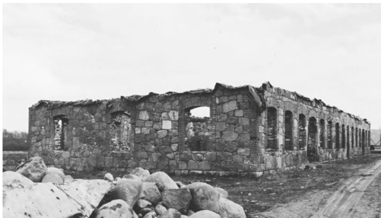
Požerės dvaro ūkinio pastato rekonstrukcijos etapai 2002, 2003, 2005 metais. V. Jocio nuotr.
