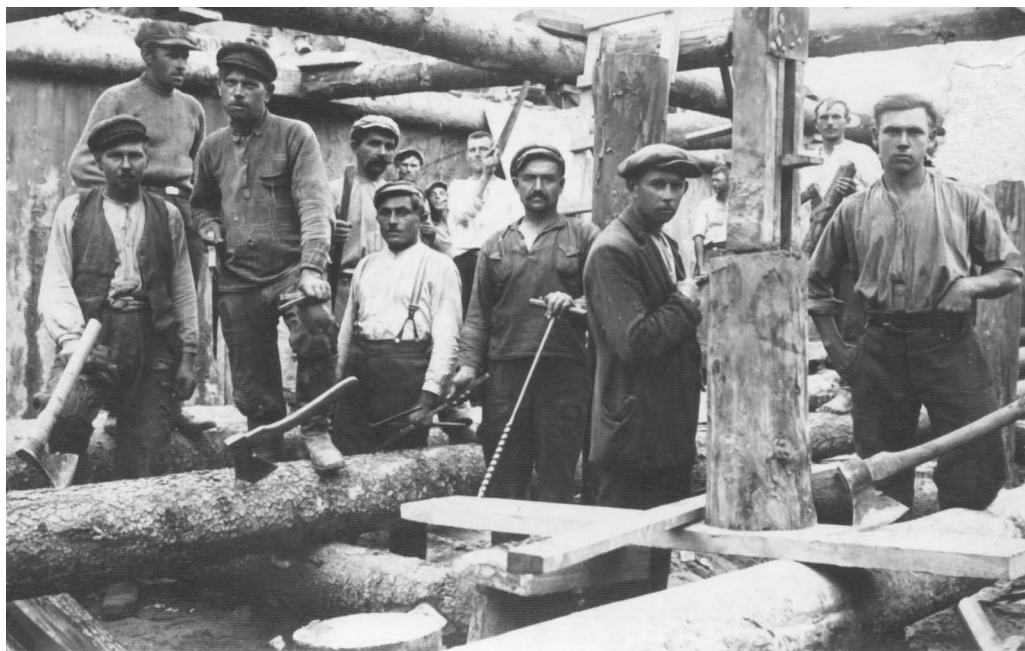
Dailidės stato Kūlupėnų geležinkelio tilto per Salantą medines laikančiąsias konstrukcijas. 1930 08 29 (Kr. MF, nr. IF649)
