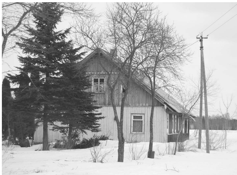
Bažnyčios klebonija prieš remontą. Vaizdas iš pietryčių. 2011 02 22. J. Valančiūtės nuotr.
