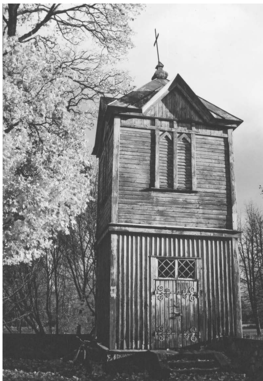
Budrių bažnyčios varpinė. 2002 m. Iš aut. rinkinio
