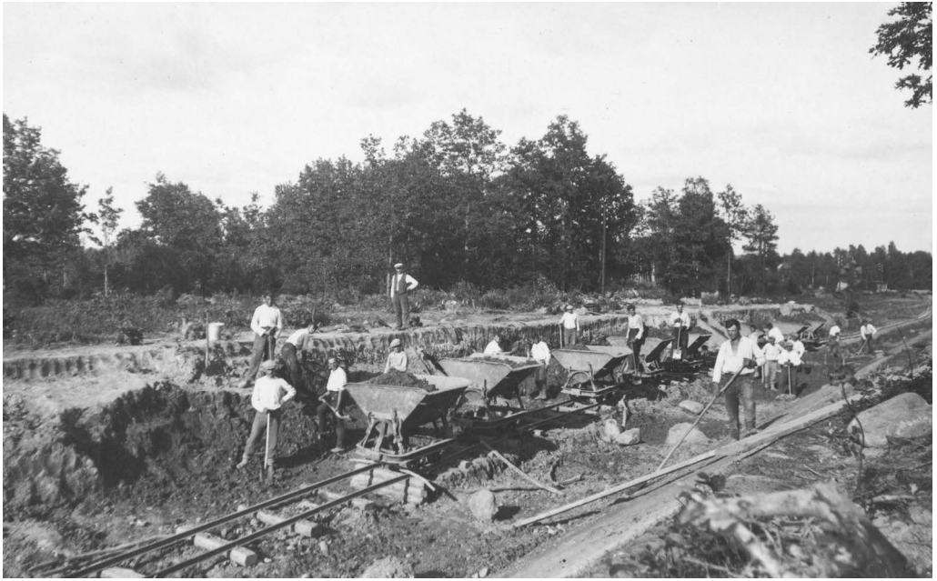
Kretingos–Telšių geležinkelio statyba ties Kūlupėnais. 1931–1932 m. Iš Prano Daukanto (Kūlupėnai) albumo
