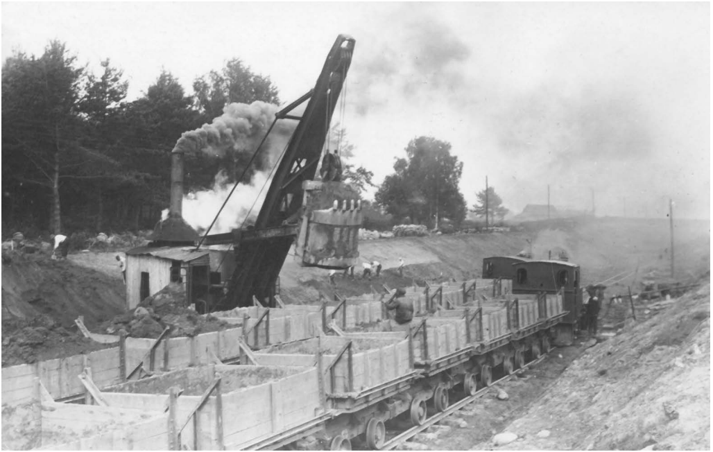
Kretingos–Telšių geležinkelio statyba ties Salanto slėniu. 1931 m. (Kr. MF, nr. IF642)
