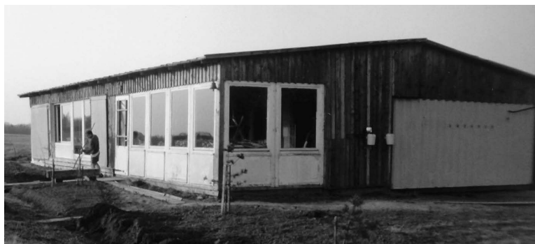
Gyvenamasis „konteinerių“ kompleksas, „Susitaikinimo sodybos“ bendruomenės namai. 1999 m. J. Kliestutės nuotr.
