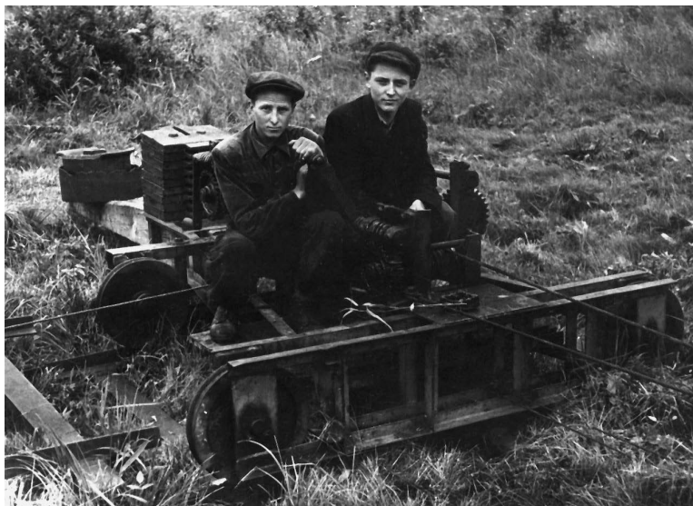
Darbų vykdytojas Algimantas Lasinskas ir Bronius Raišys prie lynų įtempimo įtaiso. 1952 m. Iš A. Lasinsko albumo
