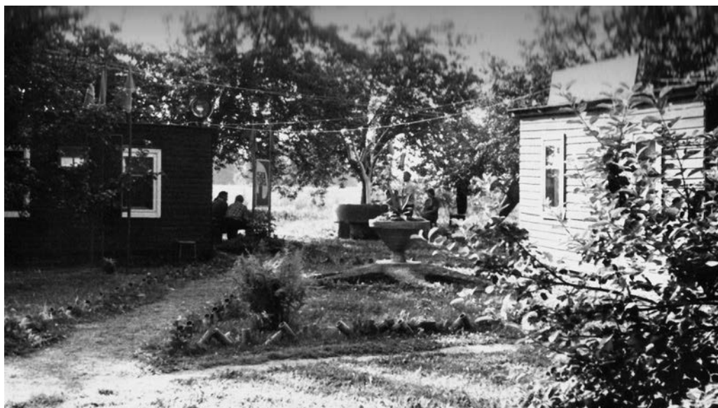
V melioracijos statybos darbų aikštelės centras „Tėvynės“ kol. (darbų vykdytojas Čepelis). 1971 m.
