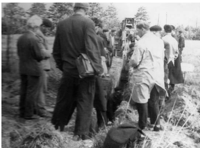
Lietuvos hidrotechnikos ir melioracijos mokslinio tyrimo instituto Melioracijos darbų organizavimo ir gamybos skyriaus vedėjas J. Navickas atvyko į seminarą apie drenažo vamzdžių izoliaciją stiklo pluoštu ir drenažo įrengimą polietileningais vamzdžiais. 1965 m.
