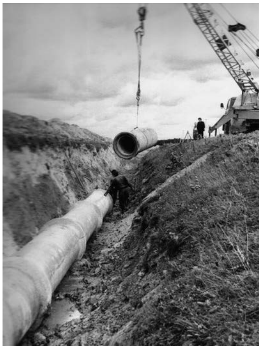
Didelio skersmens gelžbetoninių vamzdžių rinktuvas įrenginėja „Švyturio“ kol. (darbų vykdytojas Vitalijus Skėraitis, traktorininkas P. Tunikaitis, ekskavatorininkas V. Čereškevičius, darbininkai P. Dirvelis, I. Veličkienė, R. Kuncaitienė). 1977 m.
