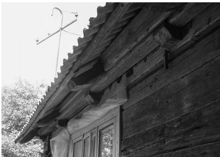
Ant viršlanginio vainiko paklotas antras rąstų vainikas, iškirstomis apie 3–5 cm gylis iškartomis sijoms įstatyti. 2003 m. D. Perkausko nuotraukos
