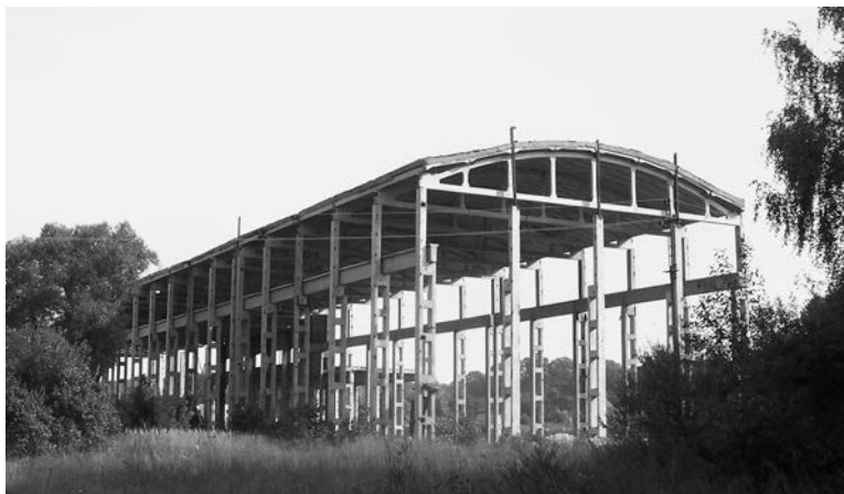
Aukštų gelžbetoninių konstrukcijų cecho karkasas, kuris ir šiandien akis bado važiuojantiems net dešiniuoju Nemuno krantu pro Šilinę. 2009 m. A. Andrijo nuotr.
