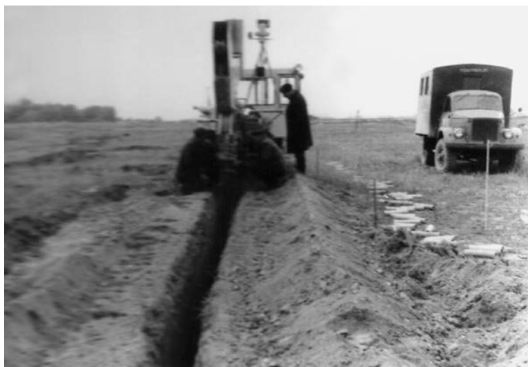
Kloja drenažo vamzdžius („Jaunosios gvardijos“ kol.). Daugiakaušį ekskavatorių prižiūri mobili techninė pagalba. 1965 m.
