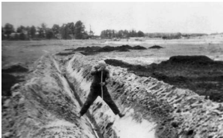
1956–1957 m. Šakių MMS drenažą įrenginėjo tik grioviakasiu iškastose tranšėjose. 1957 m.
