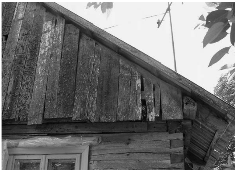
Teresės Tamošaitienės gyvenamasis namas Elizavos k. statytas iš sprindinių (gero sprindžio pločio) keturkampiai aptašytų rąstų
