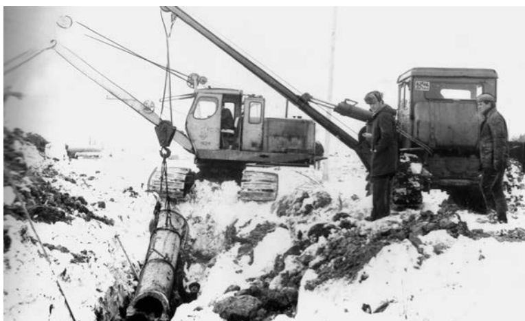
Didelio skersmens gelžbetoninių vamzdžių rinktuvas įrenginėja „Švyturio“ kol. (darbų vykdytojas Vitalijus Skėraitis, traktorininkas P. Tunikaitis, ekskavatorininkas V. Čereškevičius, darbininkai P. Dirvelis, I. Veličkienė, R. Kuncaitienė). 1977 m.
