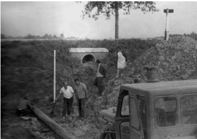
Betranšėjo praėjimo darbai. 1972 m.
