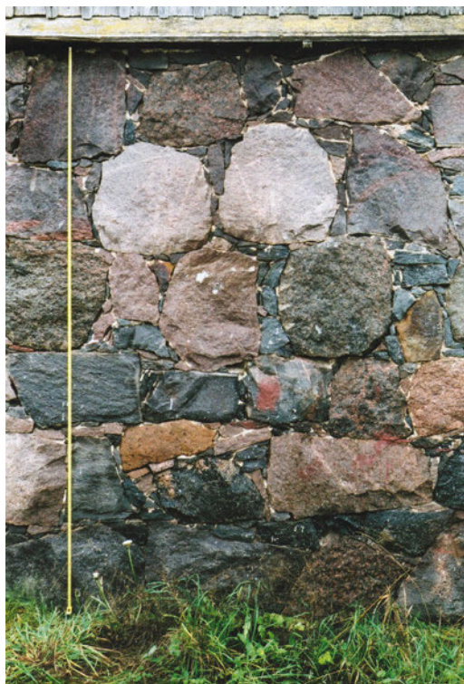
12 pav. Šešios skaldytų lauko akmenų eilės ir mūrijimo technologija matyti ryškiai Baisogalos dvaro bravoro pastato šiauriniame gale. Matuoklės ilgis 300 cm
