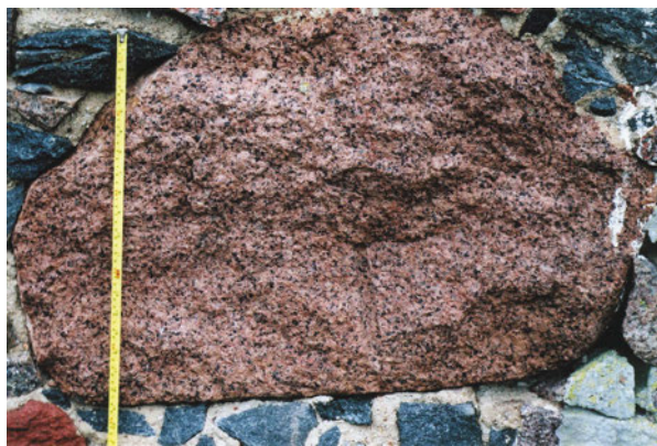
27 pav. Alandų salų smulkiagrūdis rapakyvis Valatkonių buvusio chemikalų sandėlio sienoje. Riedulys susprogdintas išgręžtoje skylėje susprogdinus sprogstamąją medžiagą. Matuoklės ilgis 54 cm
