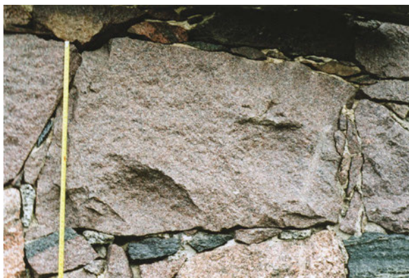
14 pav. Smulkiagrūdis Hango granitas Baisogalos dvaro bravoro pastato sienoje. Dešinėje pusėje sprogdinimo skylės liekanos. Matuoklės ilgis 59,5 cm
