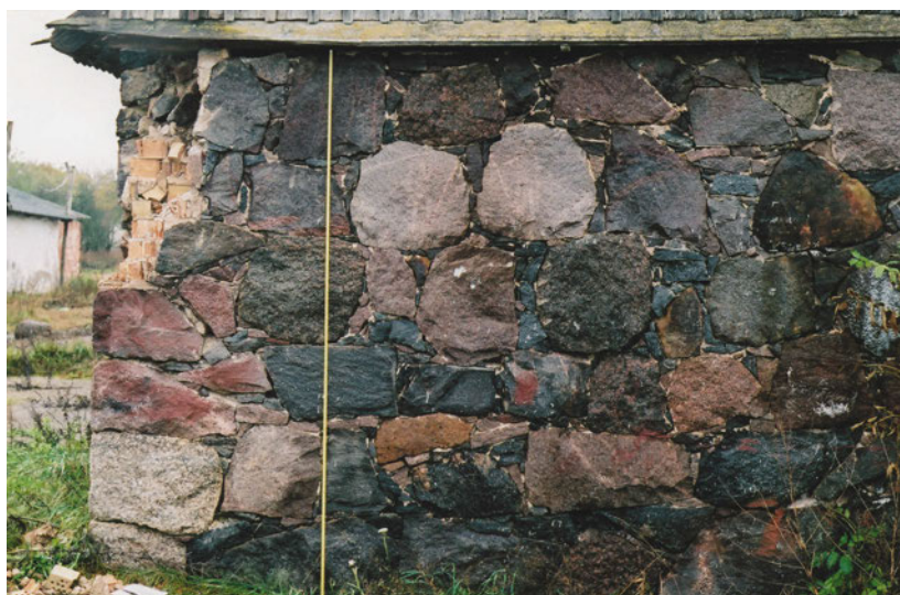
10 pav. Baisogalos dvaro spirito voryklos pastatas, kurio sienose suskaičiuoti būdingieji rieduliai. Kairiajame viršutiniame kampe – apardytas mūras, sutvirtintas plytomis
