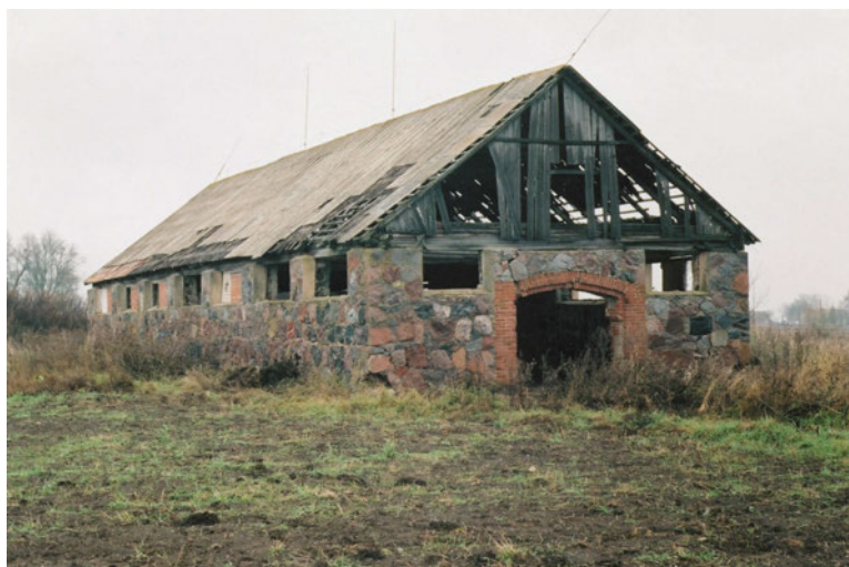
23 pav. Ūkinis pastatas Valatkonių k. prie kelio į Pociūnėlius sumūrytas iš skaldytų lauko akmenų
